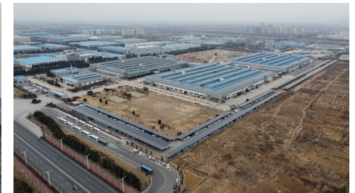
일조법인 태양광 설치 현황
